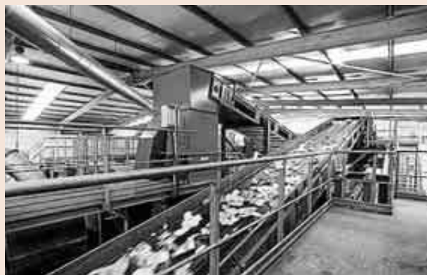
Planta de tratamiento de residuos de Griñó en Catalunya.
